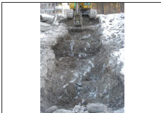
Sanerad yta golvränna mitt nordöstra delen av däckswerkstad
