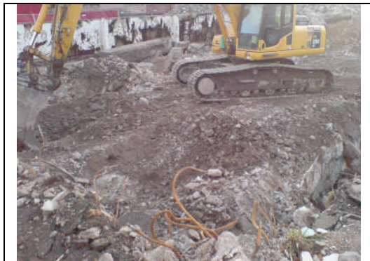
Framgrävning av bergyta nordöstra delen däckswerkstad
