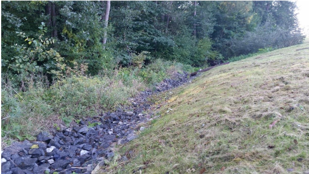
Figur 3. Runt de gamla tipparna är krossdiken anlagda.
