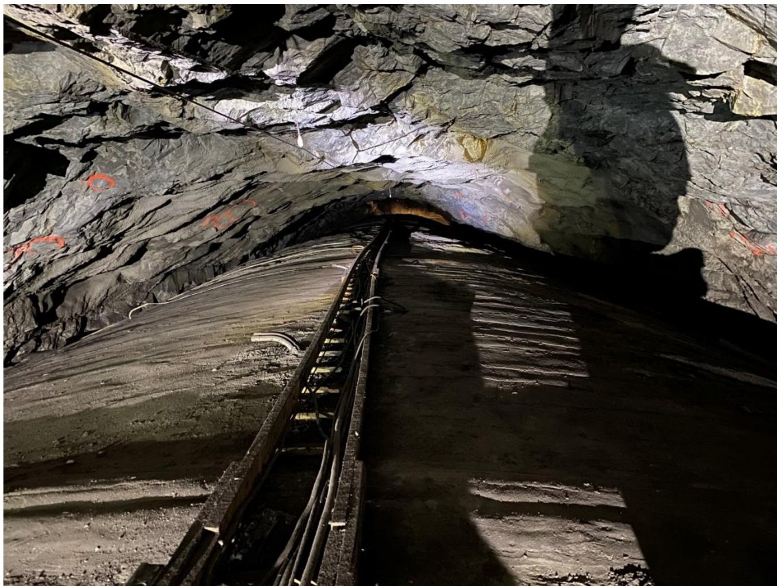
Figur 2. Utrymme mellan överkant innertak och bergkontur ovanför plattform N-gående spår.
