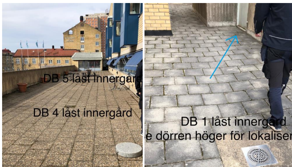
Figur 8 Låst innergård avvattnas via dagvattenbrunnar. Eventuell evakuering av visst flöde kan ske i glipan under en dörr mot sydöst
