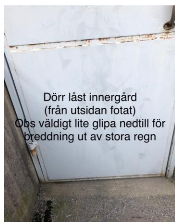
Figur 19 Port på fastighetens östra sida kan släppa ut små mängder dagvatten när porten är stängd
