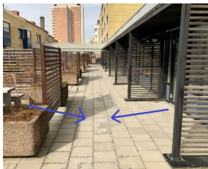
Figur 17 Svag lutning från fasad och innergårdens mitt till en avlång lågpunkt längs med fasaden där det sker avvattning via dagvattenbrunnar.
