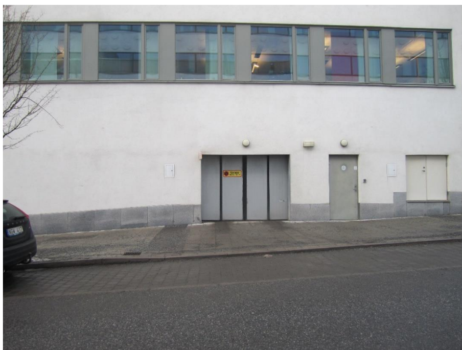
FIGUR 12 INFART TILL PARKERING UNDER HUS 4 OCH 5 FRÅN BLÅFJÄLLSGATAN
