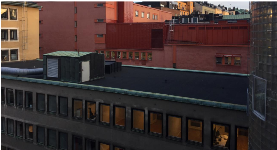
Figur 1. Nuläge: Tak med kopparkrön och kopparklätt fläktrum. Utsnitt från foto taget av Thule Fastighetsutveckling.
