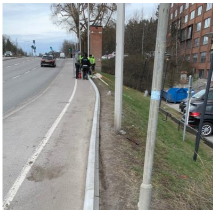
En avskiljande barriär är under uppförande mellan gång- och cykelbanan och slänten ned mot byggnaden (mars 2020).
