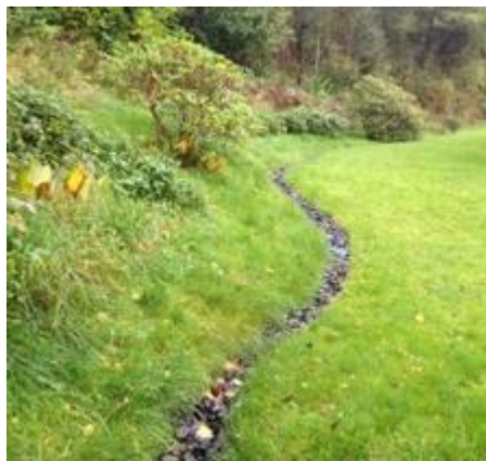
Figur 9 Exempel på avskärande dike i naturmarksslänt.
