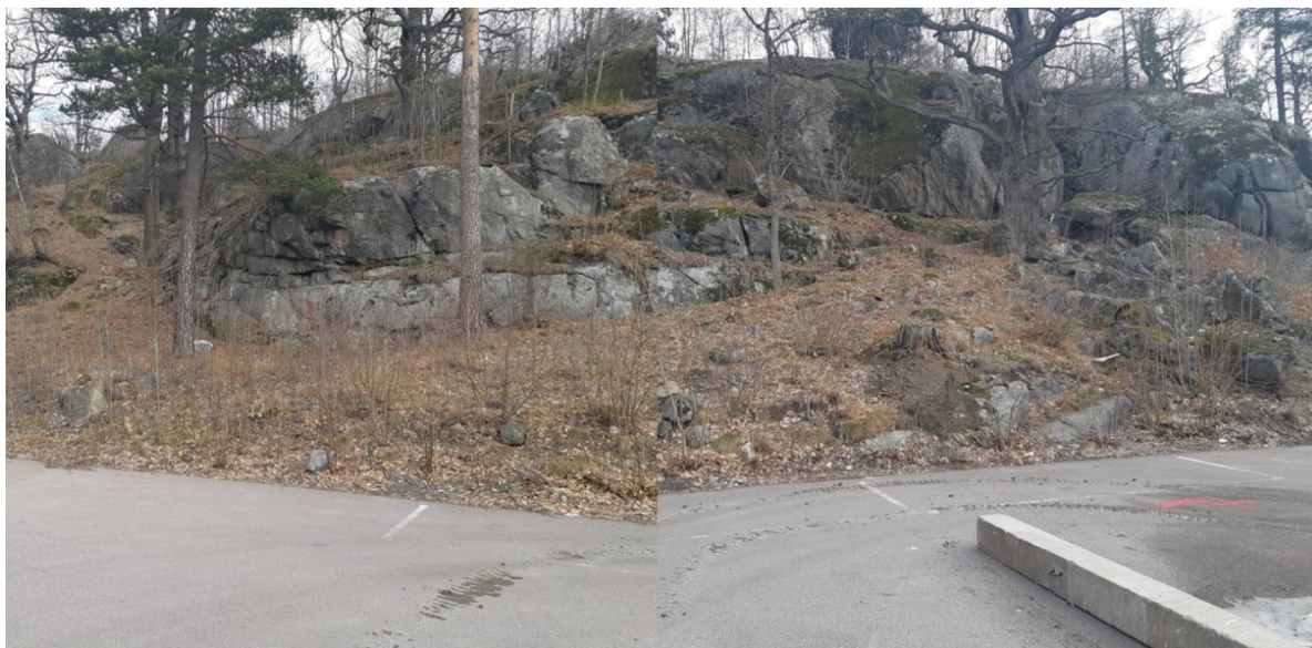
Figur 2. Vy mot bergslänt från plats där Max restaurang ska anläggas. Nedfallna block som fångats upp i jordslänten syns huvudsakligen till höger i bilden.
