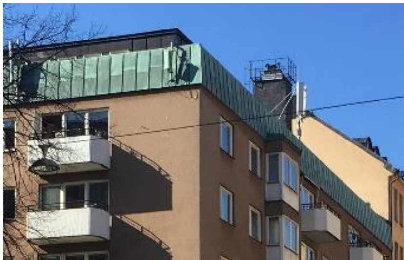
Kopparplåten löper runt hela byggnaden med avbrott för brandgaveln.
