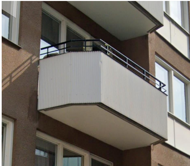
Balkongerna är utformade med heltäckande front och avfasade hörn. Undersidorna är målade i vit kulör.
