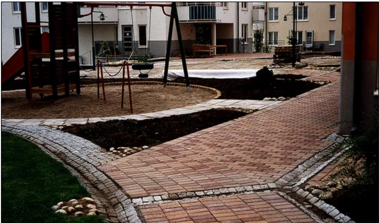
Figur 5-5. Exempel på avledning av takvatten via rännor anlagda med gatsten (Källa: Stockholm Vatten AB, n.d.).
