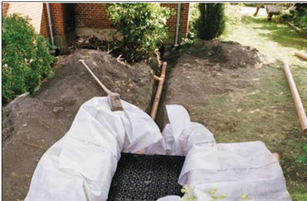
Figur 15: Exempel på utjämningsmagasin i form av dagvattenkassetter (Foto: Wavin)
