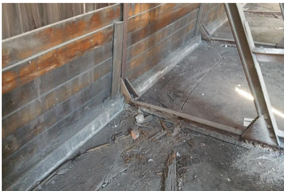
Bild 3. Betongplatta och eftergjuten sockel.
