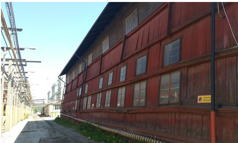
Bild 4. Bjälkarna på utsidan av sneda fasaden.
