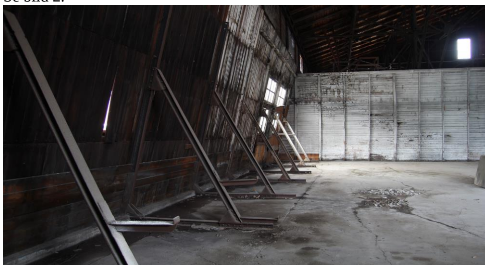
Bild 2. Stålbockarna som stöttar fasaden.
