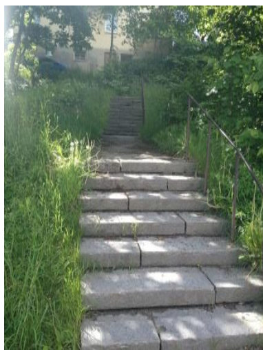
Terrängtrappor anläggs längs stråken där de topografiska förutsättningarna kräver det
