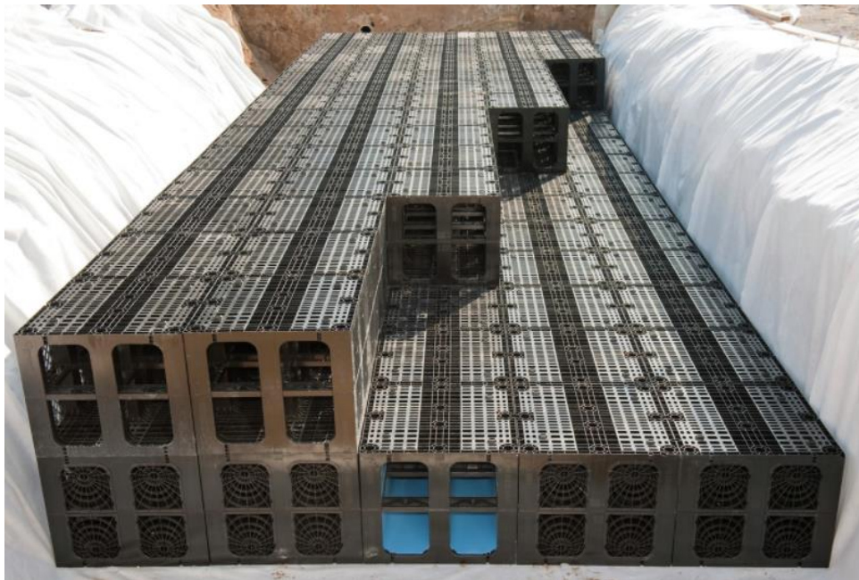
Figur 6. Exempelbild på dagvattenkassetter och hur dessa kan placeras.
