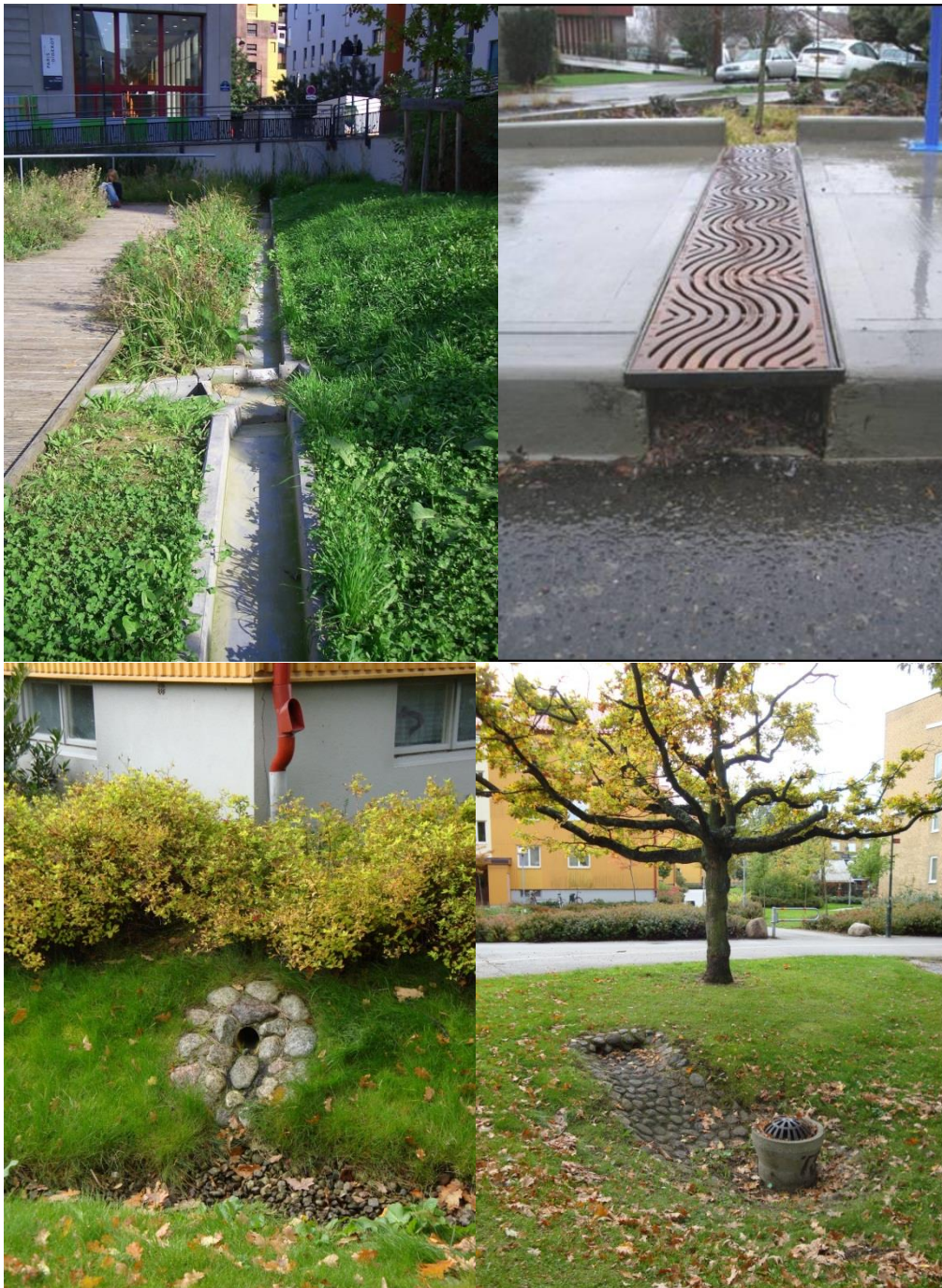
Figur 10 Övre bilder visar avledning i ränna samt släpp genom gångväg. Nedre bilder visar erosionsskydd vid dagvattenutlopp i parkmiljö.
