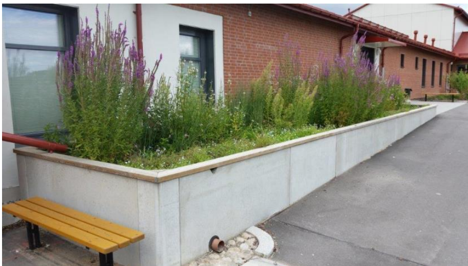
Figur 17. Upphöjd växtbädd med utlopp vid marknivå.
