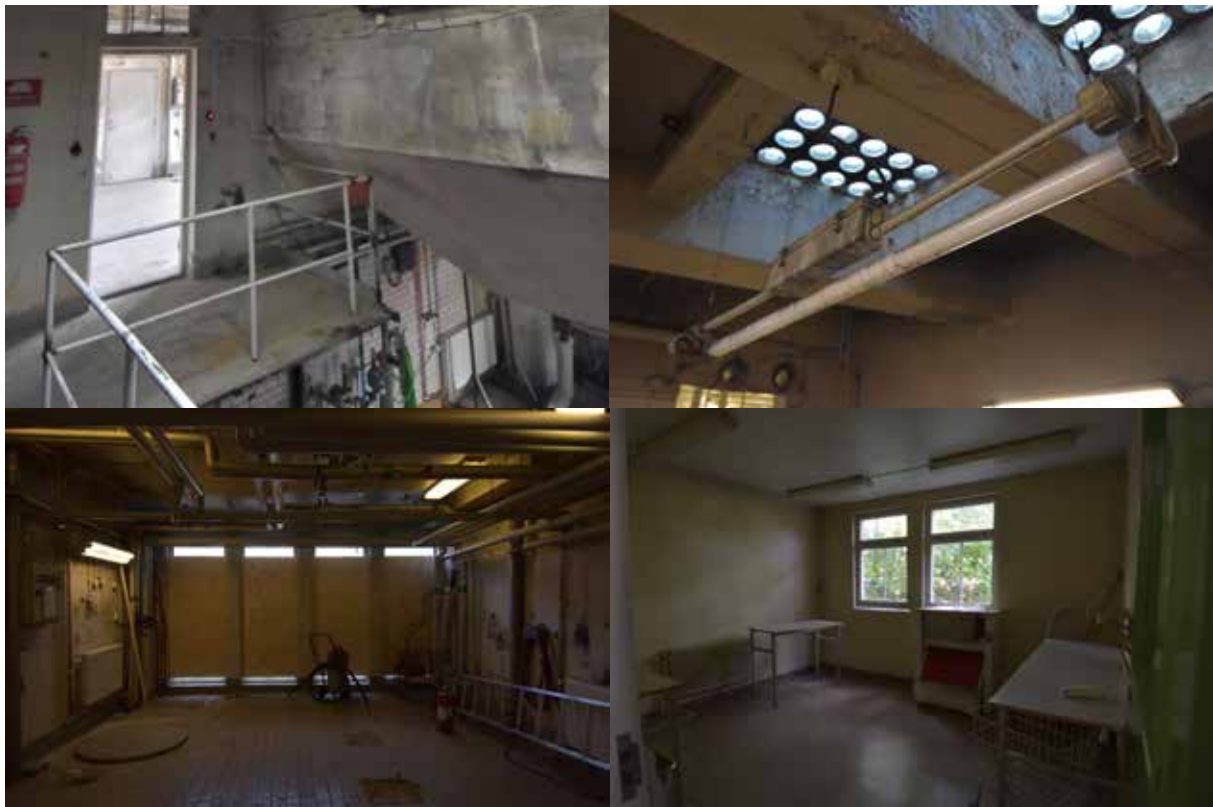
Interiör från pannhusets entresolplan mot apparatrummet, Pannhusets kassettaksliknande balkkonstruktion med fyllningar av betongglas, Interiör från apparatrummet. Fönstren har täckts för med skivor, Interiör från en av tvättstugorna.
