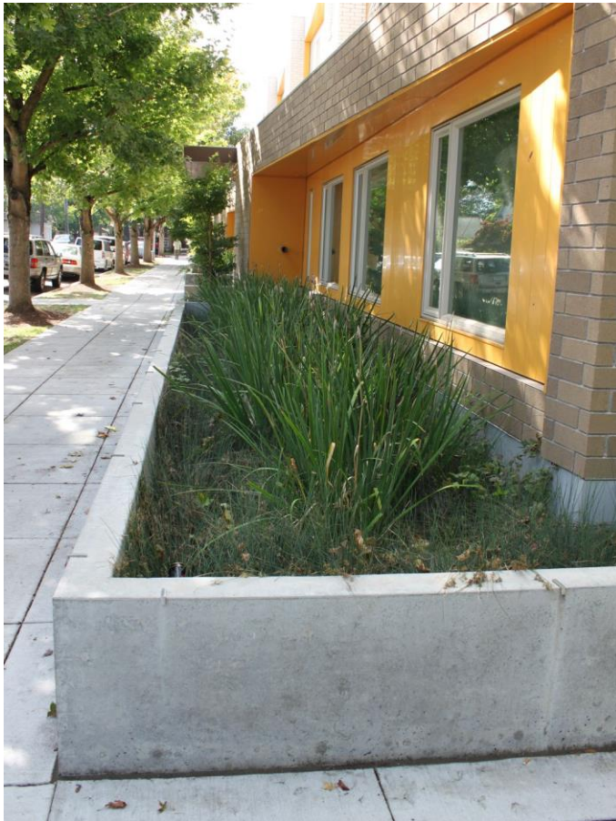
Figur 9. Exempel på nedsänkt växtbädd, utformad som upphöjd planteringslåda. Foto WRS.
