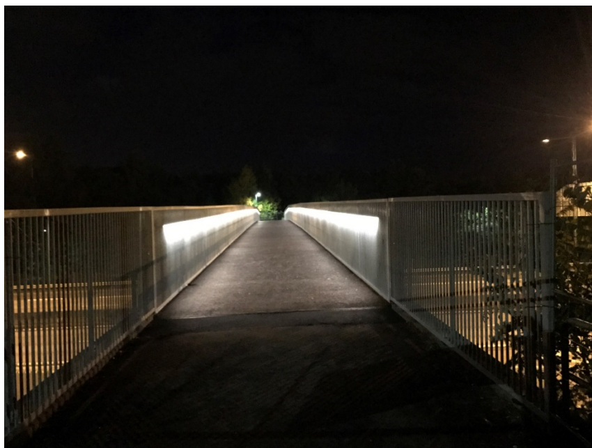
Figur 3 Ny bro. Ledbelysningen längs hela bron för att undvika mörka partier. (bild Jönköpings kommun)
