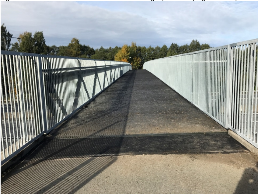
Figur 2 Ny bro. Broräcket har 8 cm mellan spjälor och är 1,8 m högt. (bild Jönköpings kommun)
