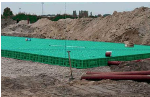
Figur 22 - Exempel på kassettmagasinlösning från Pipelife. Källa: pipelife.se.
