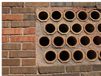
Inmurade dräneringsrör i parkeringshusens våningsplan
