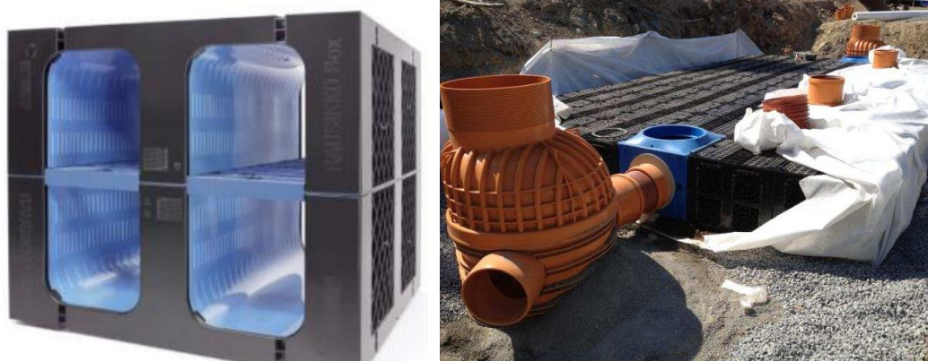
Figur 9. Dagvattenkassett och kassettmagasin under anläggning.
