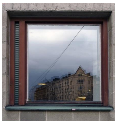
Ursprungligt rödbrunt träfönster i murverk, med sidoförskjutet vädringsgaller och fönsterbleck av kopparplåt.
