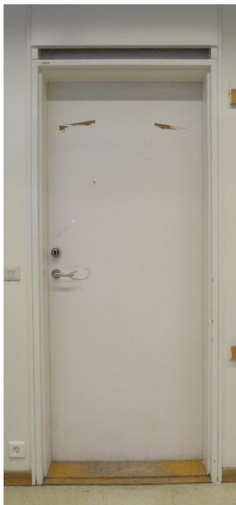
Karaktäristisk, slät vitmålad dörr till kontorsrum, med överluftsdon med ljudficka och kraftig profilerad karm.
