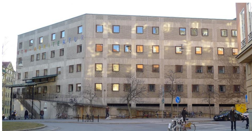
Högdelsens fasader mot Danderydsplan och Östermalmsgatan, med exponerad gjuten betongstomme, fyllningar av murade betongblock, likformiga fönsterhål
