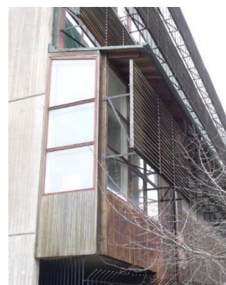
Panelklätt burspråk med solavskärmning av träribbor på järnkonsoler. Stående mörkbrun spåntpanel av furu.
