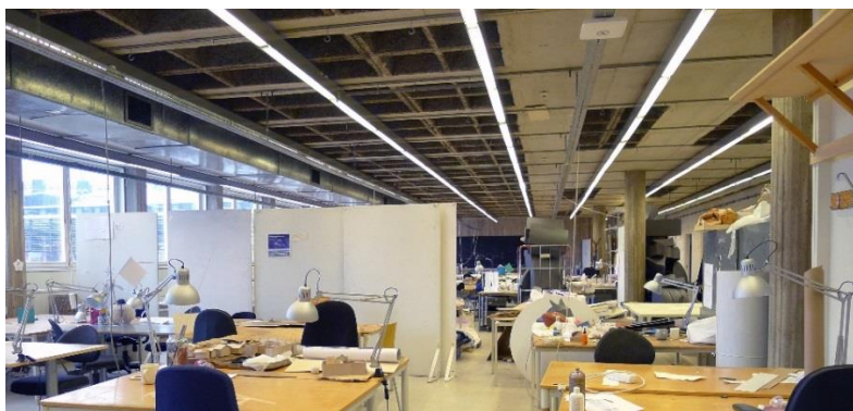
Tak av slät betong med ingjutna ljudabsorbenter av träullscement i ritsal. Synliga installationer i tak.
