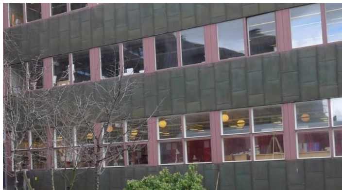
Innergårdens ursprungliga fönsterband av rödbruna träfönster med olika typ av indelning (den rödbruna kulören något blekt). Fasaden i stånfalsad skivplåt av koppar.
