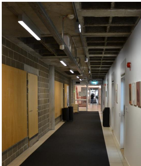
Ursprunglig bevarad planlösning på plan 2. Centralt placerad korridor i flygelns längdriktning. Innervägg av synliga obehandlade murade betongblock. Vägghängda utställningsskärmar klädda med abachiträ. (foto: WSP)
