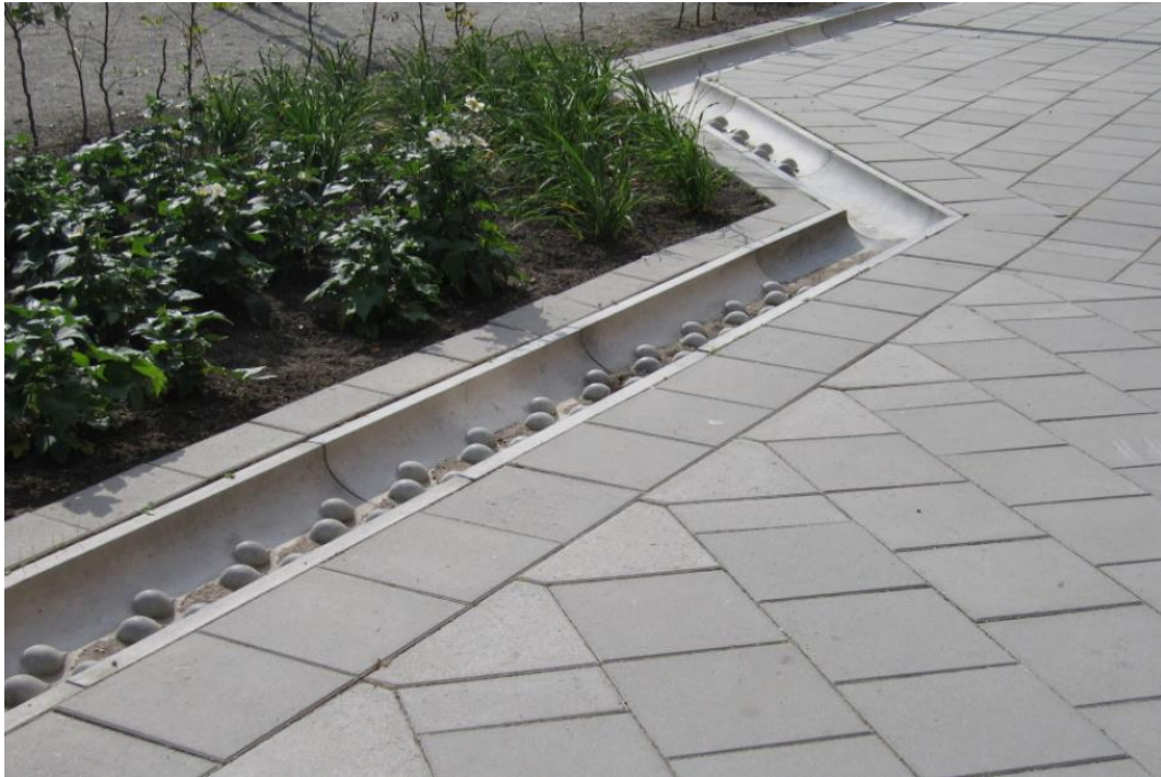
Figur 12. Rännalsplattor för avledning av dagvatten mot raingårdens.
