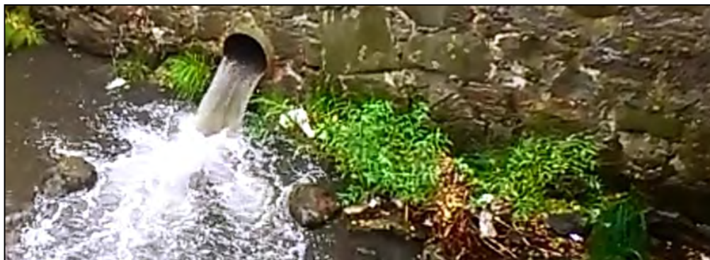
Figur 6.5 Bräddavlopp. I detta fall har spillvatten bräddat över till dagvattennätet (foto: Anders Larsson, 2013).
