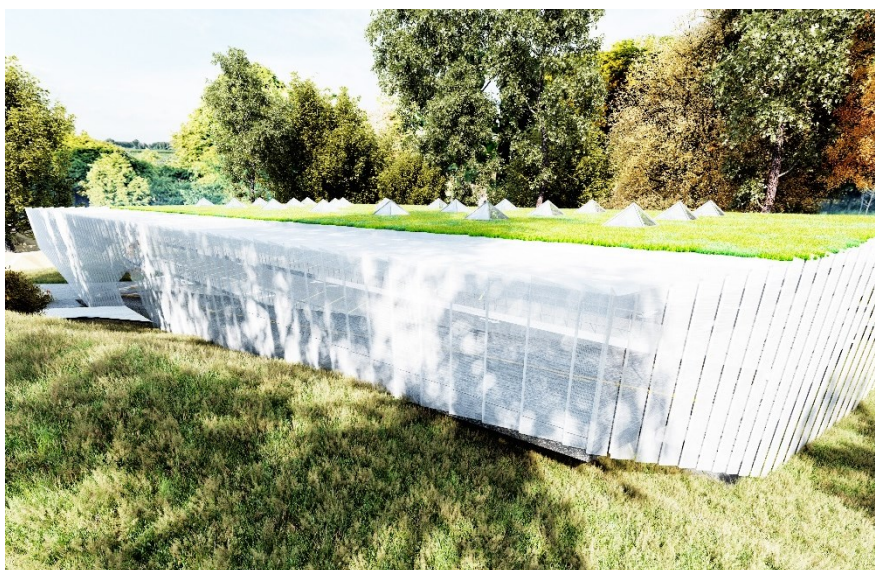
Perspektivbild som visar möjlig utformning av parkeringshuset med tre våningar, vy från sydväst. På taket ska finnas vegetation för att fördröja dagvatten. Bild: Wählin Arkitekter
