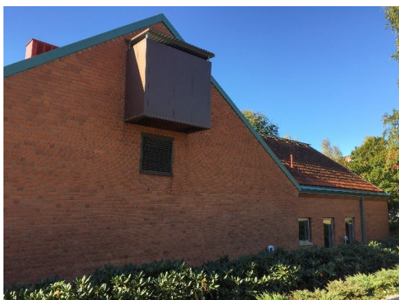
Tillbyggnaden från början av 1980-talet. Delen till höger i bild föreslås rivas. Gavelfasaden till vänster i bild hör till förlängningen av en av anläggningens ursprungliga tegellängor.
