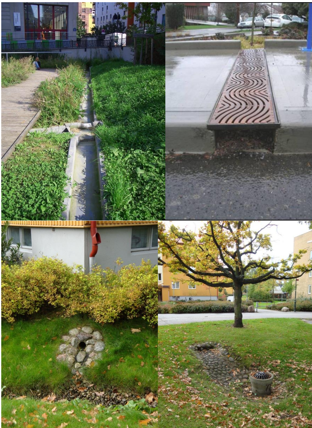
Figur 9 Övre bilder visar avledning i ränna samt släpp genom gångväg. Nedre bilder visar erosionsskydd vid dagvattenutlopp i parkmiljö.
