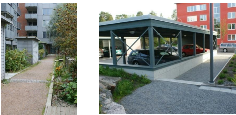
Figur 13. Exempel på permeabla beläggningar i Stockholm och Oslo.
