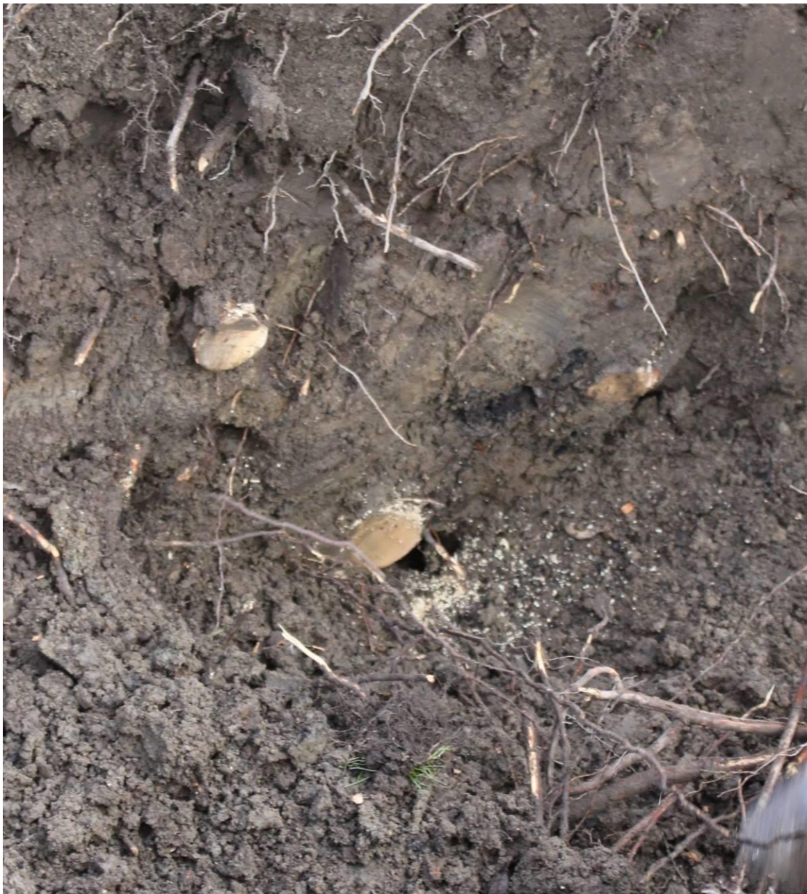
Bild 4. Korrekt beskurna rötter vid schakt.
