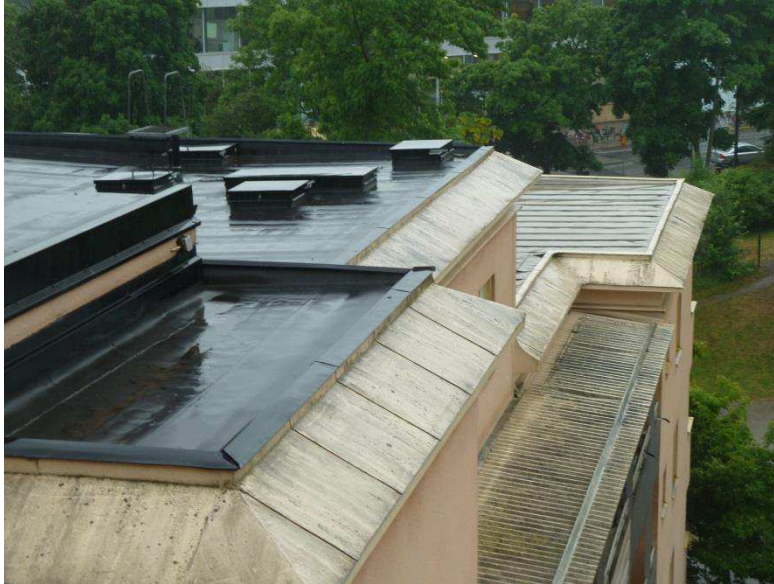
Bild Låglutande tak med plåt- och papptäckning
