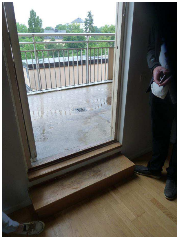
Bild Den högre liggande terrassen innebär stor risk för vatteninträngning både i lägenhet och i konstruktioner
