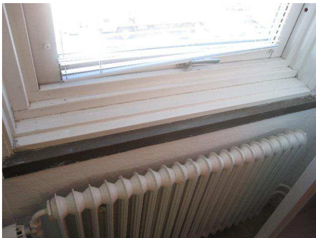
T v: Fönsteröppning med modernt insticksfönster och i flera steg övertäckt fönsterbänk. Nedanför finns ursprunglig radiator med smala lameller, likt det i trapphuset ovan. T h: Del av verkstadsinredning.
