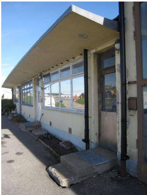
T v: Kontorsdelen med dess slanka avsmalnande uppåtriktade skärmtak. Den flagande och lagade dörren närmast leder ner till källaren.
