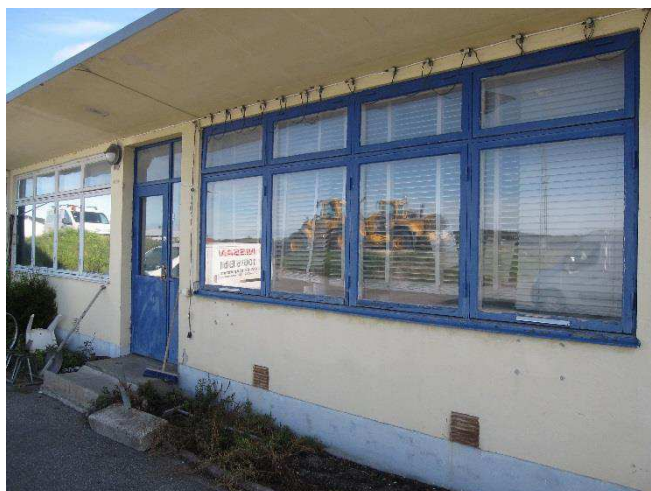
T v: Kontorsdelen med dess slanka avsmalnande uppåtriktade skärmtak. Den flagande och lagade dörren närmast leder ner till källaren.
