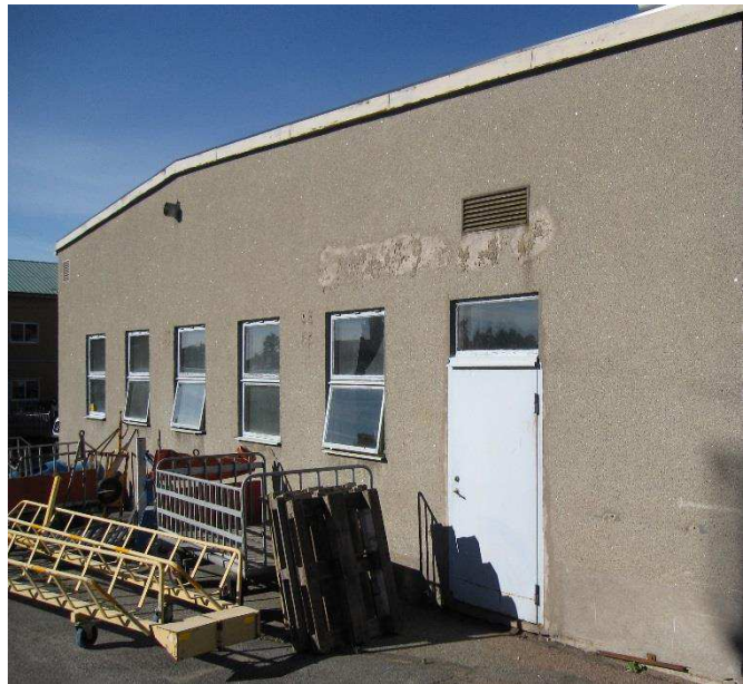
T v: Trappan på baksidan används inte. Betong och smidesräcke är välbevarade men i stort renoveringsbehov. T h: Södra gaveln med bevarad glimmerputs och ursprungliga fönster.
