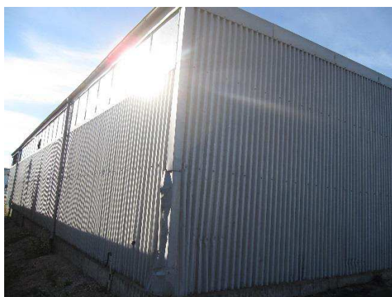
Byggnadens baksida. T v: Nordöstra knuten har påkörningsskador. T h: Fyra utslagna fönster och en invändig påkörningsskada. Det anslutande transformatorhuset och del av förrådstältet.
