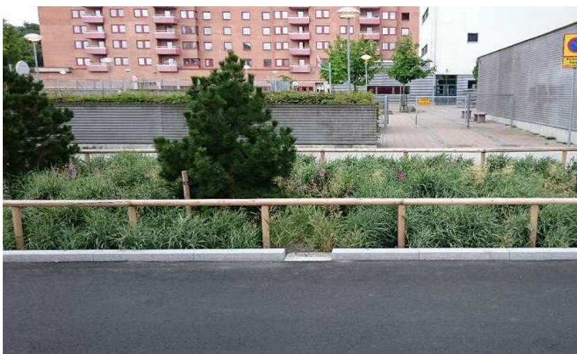
Figur 9: Nedsänkt växtbädd med inlopp genom nedsänkt kantsten. (sigmacivil.se)
