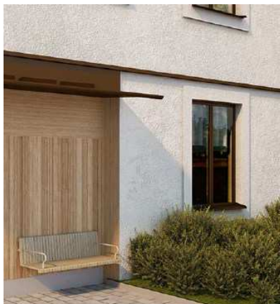
Sockelvåningen markeras med en plåtlist i samma kulör som övriga plåtdetaljer. Bild White.
