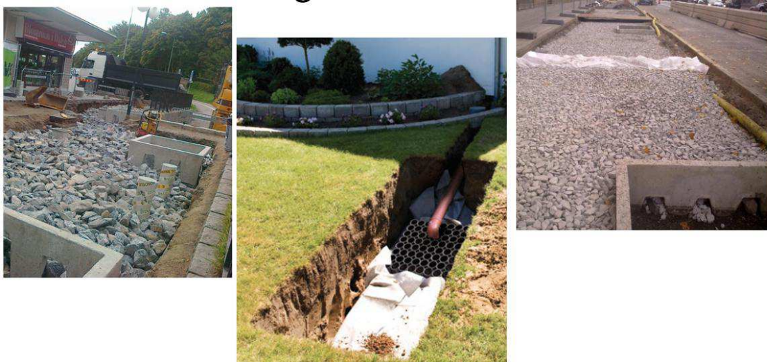
Figur 7. Förslag för olika former av LOD genom infiltration/skelettjord samt en mindre infiltrationsanläggning för avrinning från tak, samtliga exempel från Stockholm.
