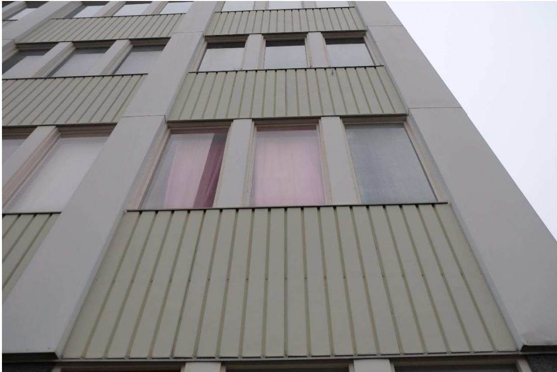
Fasadens uppbyggnad med trapetskorrugerad plåt och fönster i fack mellan vertikala pilastrar klädda med vit plåt.
