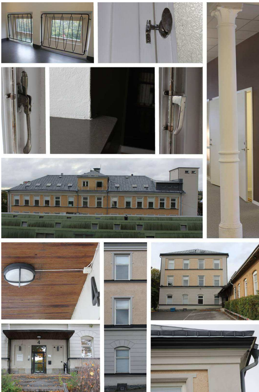
Bilder ovan: Detaljbilder från byggnaden "Slottet". Gjutjärnsdetaljerna är en av få kvarvarande originaldetaljer. I övrigt finns inslag från byggnadens olika ombyggnationer, i synnerhet från 1950-tal.
