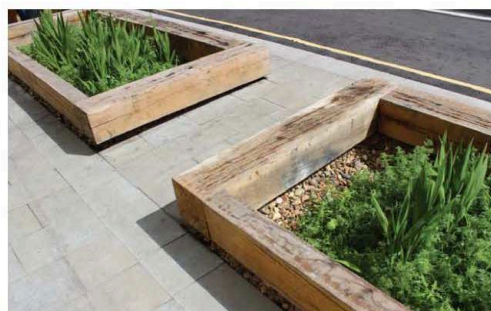
3. Regnträdgårdar. I lågpunkter mot gatan placeras en rad regnträdgårdar som kan samla upp dagvatten ifrån fastigheten.
