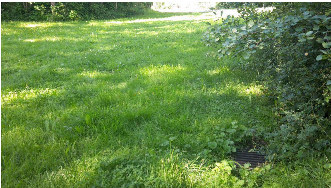
Figur 5. Dagvattenbrunn i lågpunkt inom omdaningsområdets södra del. Brunnen ligger belägen ungefär där tredje bostadshuset sett söderifrån kommer byggas i långa L2.
