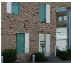
Exempel på vädringsluckor placerade intill fönster, och som bidrar till variation i fasaden. Bild till höger visar exempel på en varmttonad metall, som är lämplig för vädringsluckorna.
