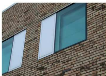
Exempel på vädringsluckor placerade intill fönster, och som bidrar till variation i fasaden. Bild till höger visar exempel på en varmttonad metall, som är lämplig för vädringsluckorna.
