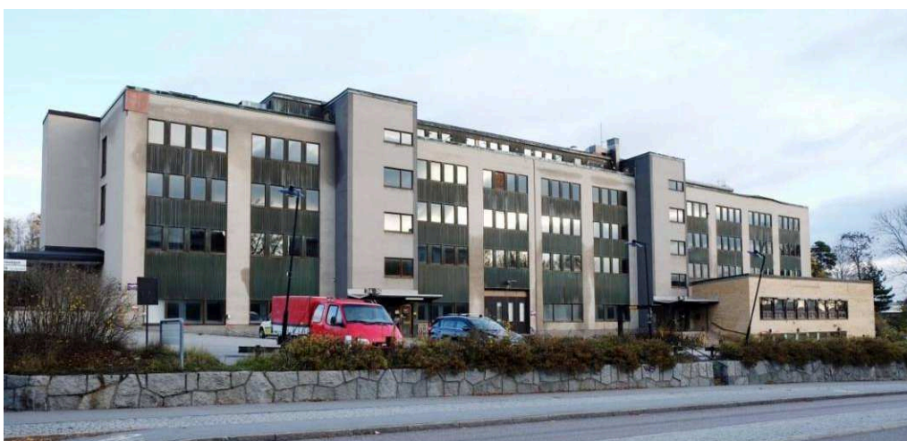
Befintlig byggnad mot Bällstavägen. Byggnaden karaktäriseras av fasadens konsekventa fältindelning, med stående kopparbeklädda partier.
