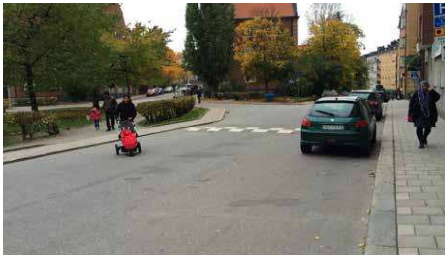
Bild. Fartguppet norr om den omarkerade passagen dit barn och ungdomar använder när de genar över rondellen rekommenderas att flyttas söder om passagen.
