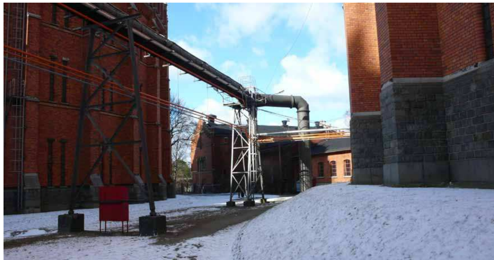
Vy 42. Gasledningen med stöd B i förgrunden och stöd C längre bort.
