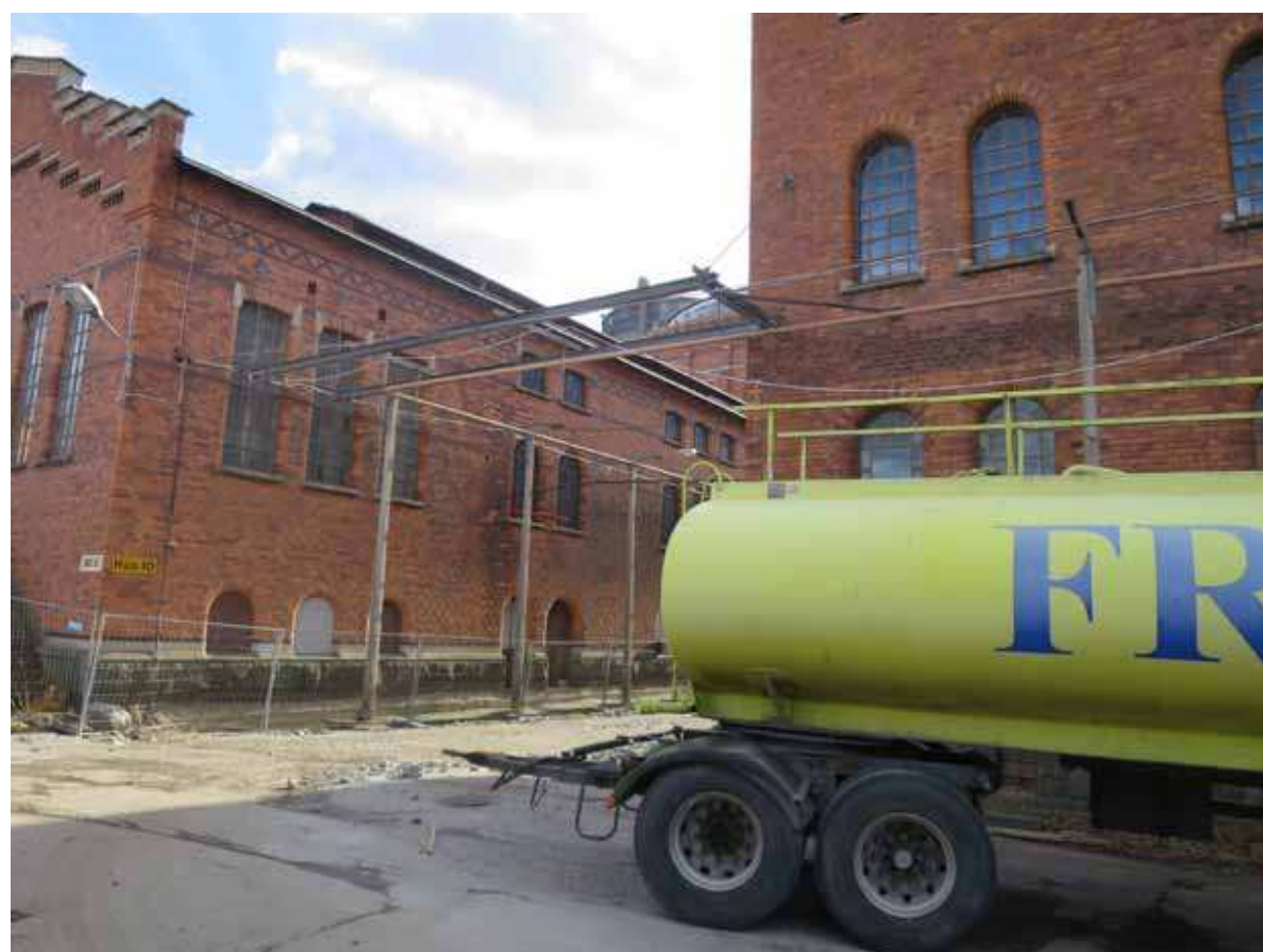
Vy 6. Norra ledningsstråket böjer av vid hus 9 och ledningarna leds längs hus 10. Ledningsstråkets stålram mitt i bilden är linspänd från husens fasader.
