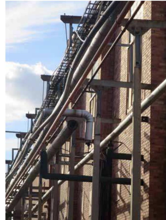
Vy 15. Ledningsstråket längs sydfasaden Ångkraftcentralen hus 21.
