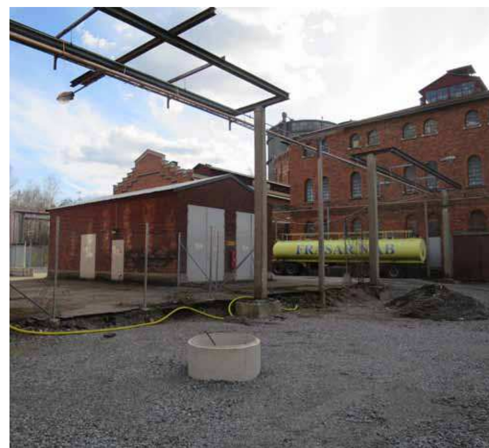
Vy 7. Stålramar på grövre betongstolpar mellan hus 14 och 9.
