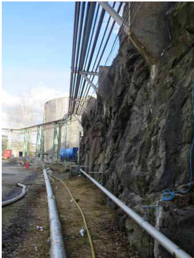
Vy 33. Södra ledningsstråket på konsoler längs bergsskärningen.
