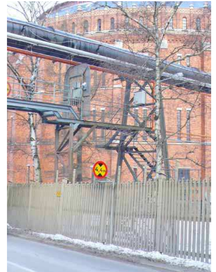
Vy 39. Gasledningen på stöd A med trappa och gångbrygga över Gasverksvägen.
