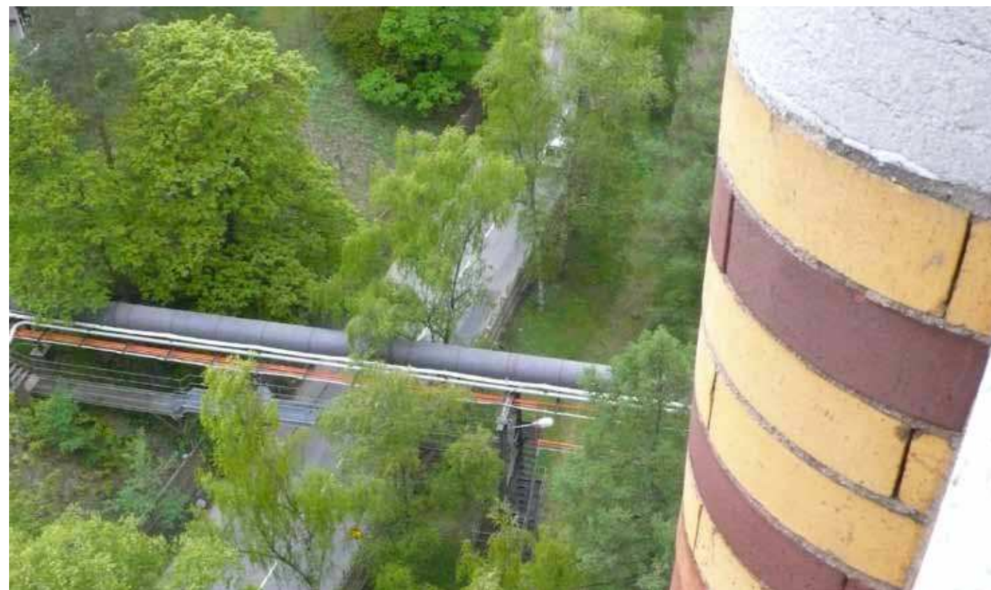
Vy 46. Gasledningen med gångbrygga över Gasverksvägen.
