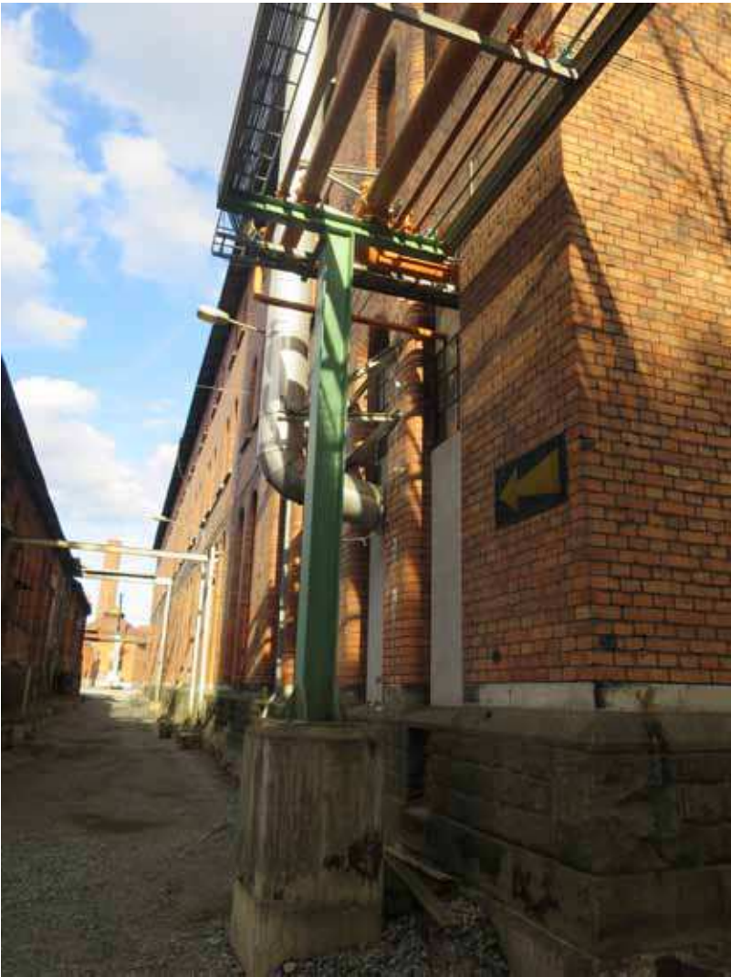
Vy 50. Luftledning på konsol och stolpe av stål vid hus 9.
