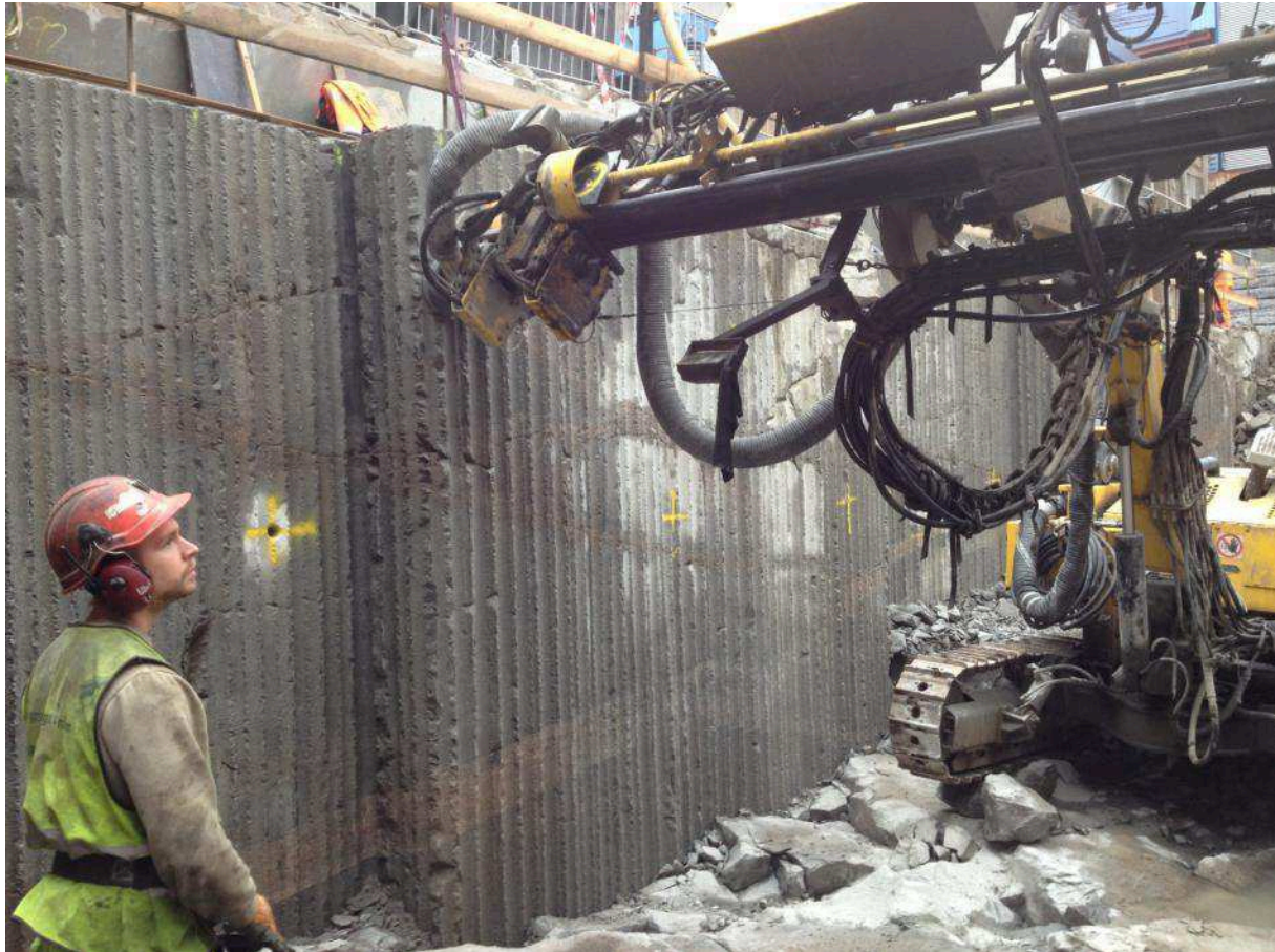
Figur 7. Slitsborrning från bergskärning vid Odenplan. Man borrar hål i hål.
