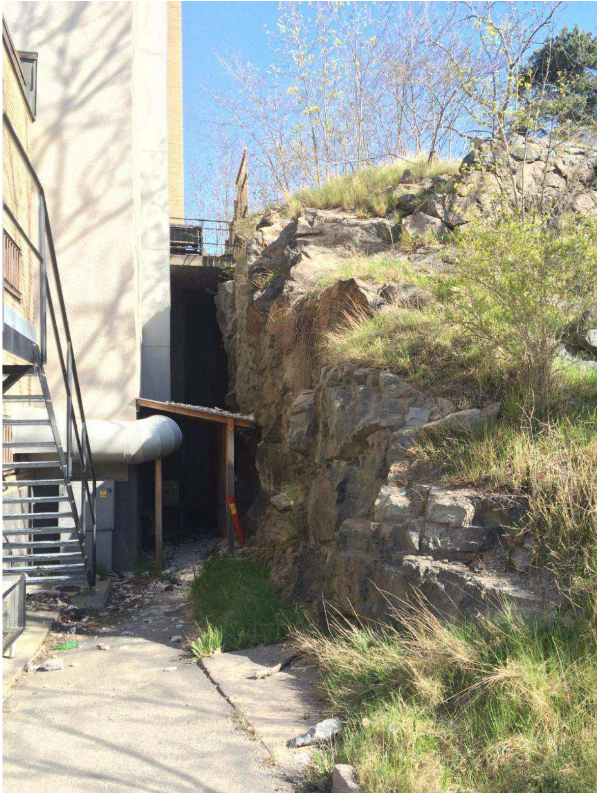
Figur 14. Förbultning av befintliga slänter kommer att krävas för att säkerställa en trygg arbetsmiljö.
