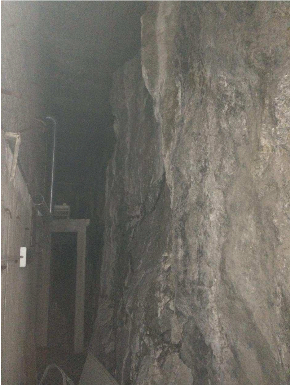
Figur 15. Bild tagen mellan bergvägg och husliv. Flera krosszoner genomsär slänten. På grund av detta anses bergsågning inte en bra metod.
