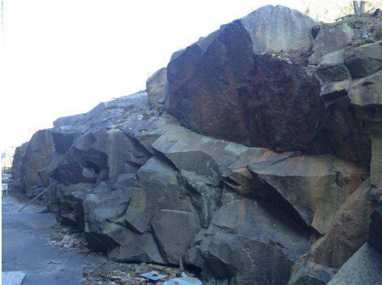
Figur 11. Olika sprickplan orsakar ett ojämnt släntrön.
