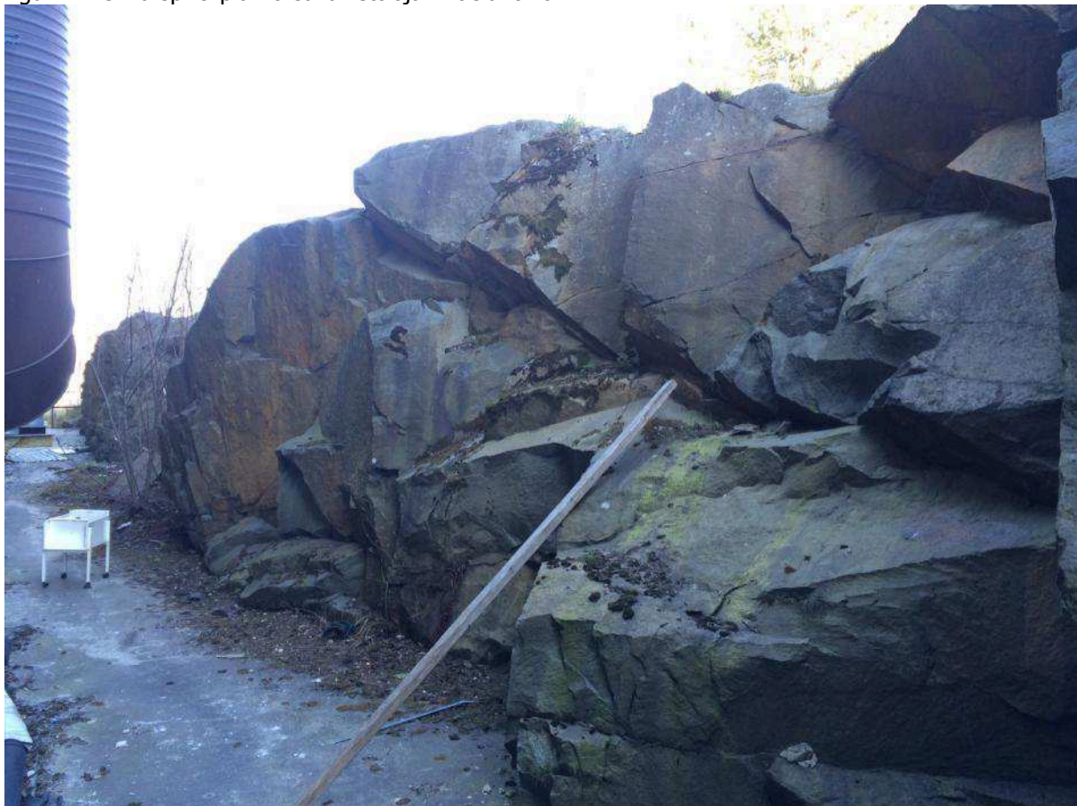
Figur 12. Olika sprickplan orsakar ett ojämnt släntrön.
