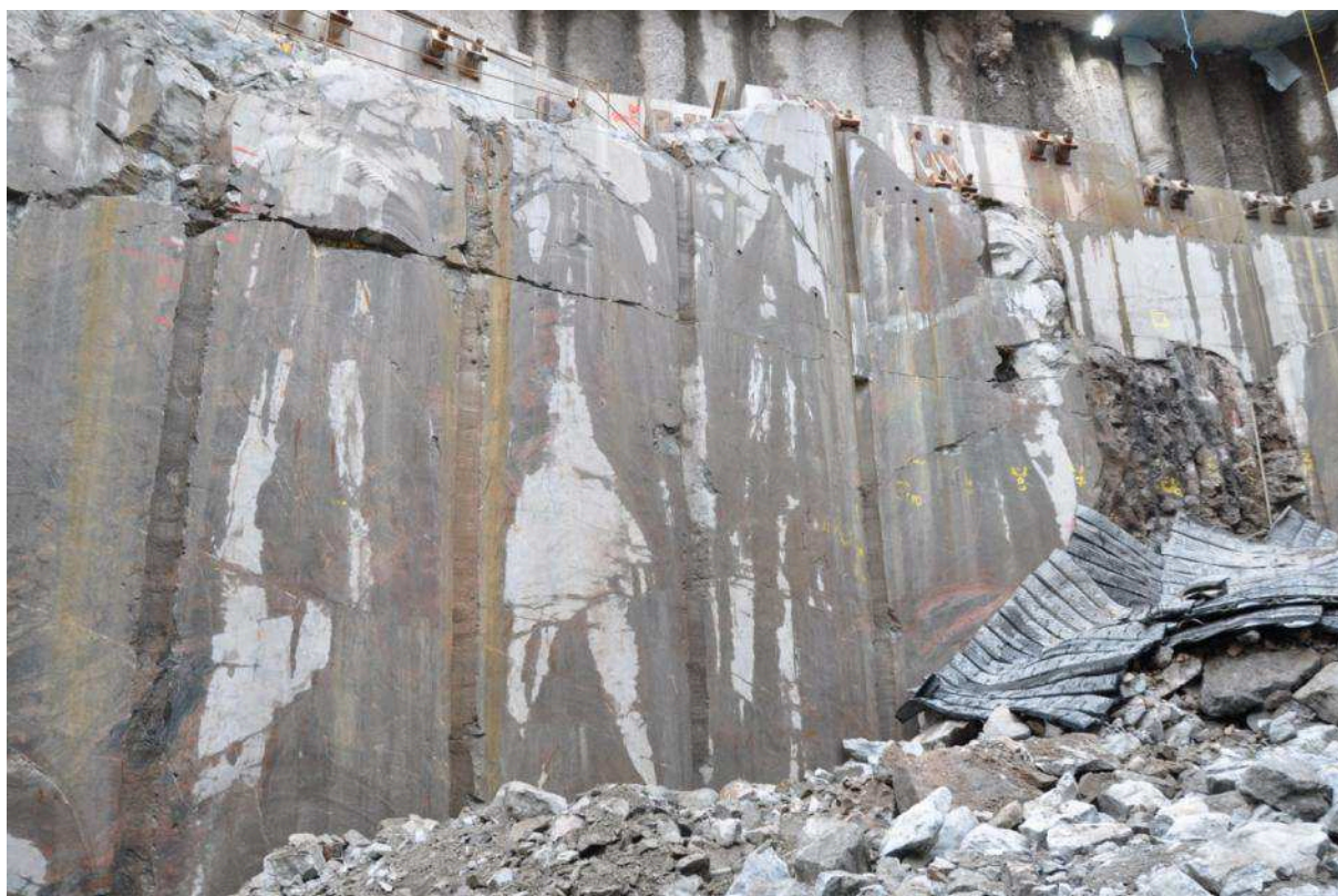
Figur 4. Exempel på sågade bergväggar från bergschakt på Riddarholmen.
