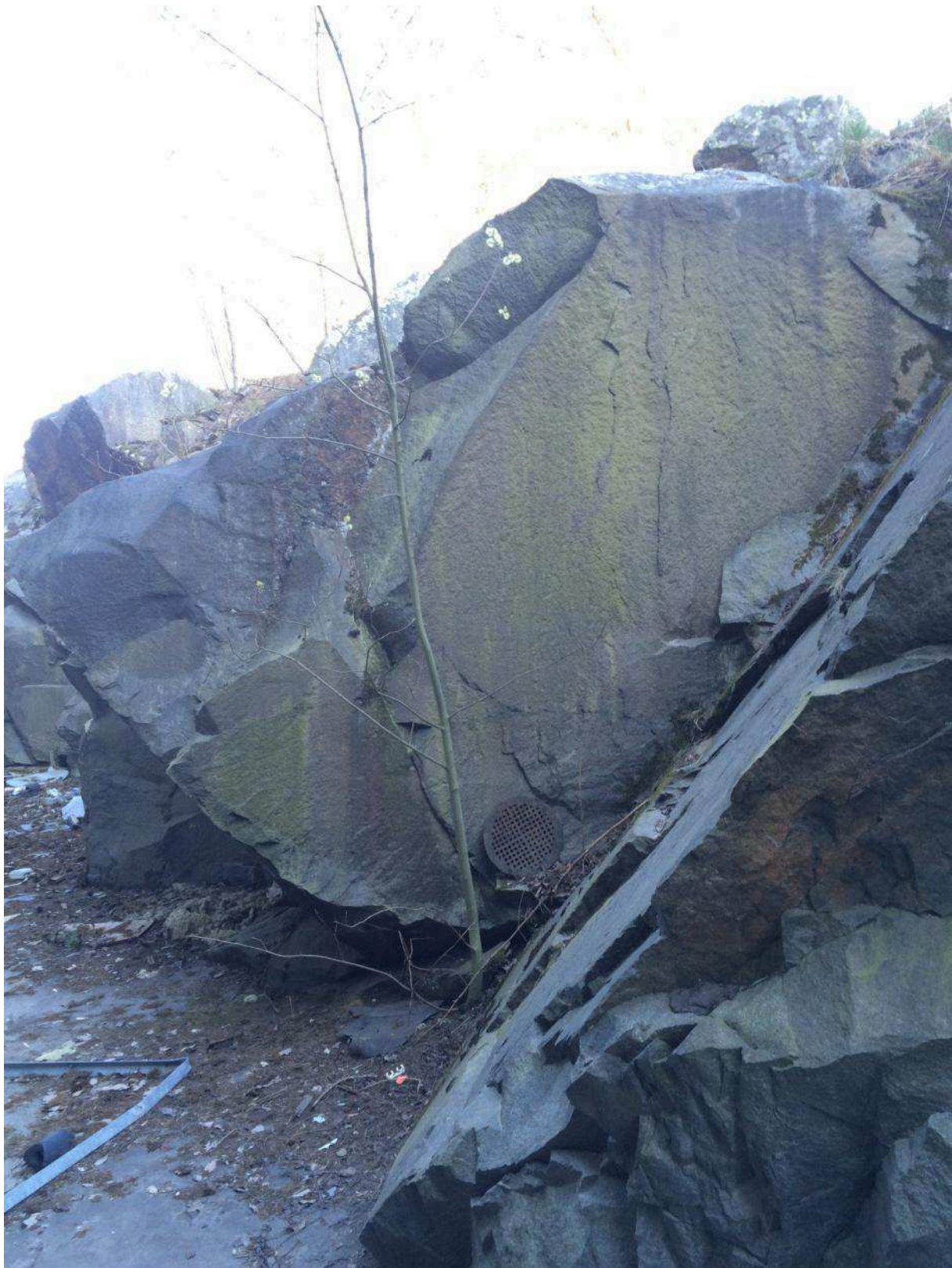
Figur 10. Ogynnsam sprickorientering har orsakat bakbrytning vid tidigare schaktning och intrång i grannfastigheten. Sannolikheten att detta kommer att inträffas igen vid ny bergschakt är stor.
