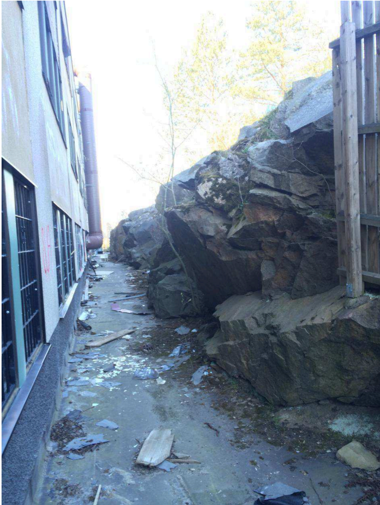
Figur 9. Olika sprickplan orsakar ett ojämnt slänkrön. Berget fortsätter nedåt.
