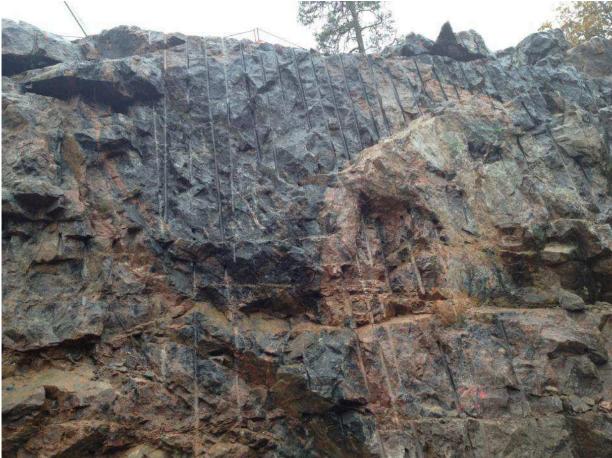
Figur 6. Sprängd tätsöm cc 40 cm från bergschakt vid Kvarnholmsförbindelsen.
