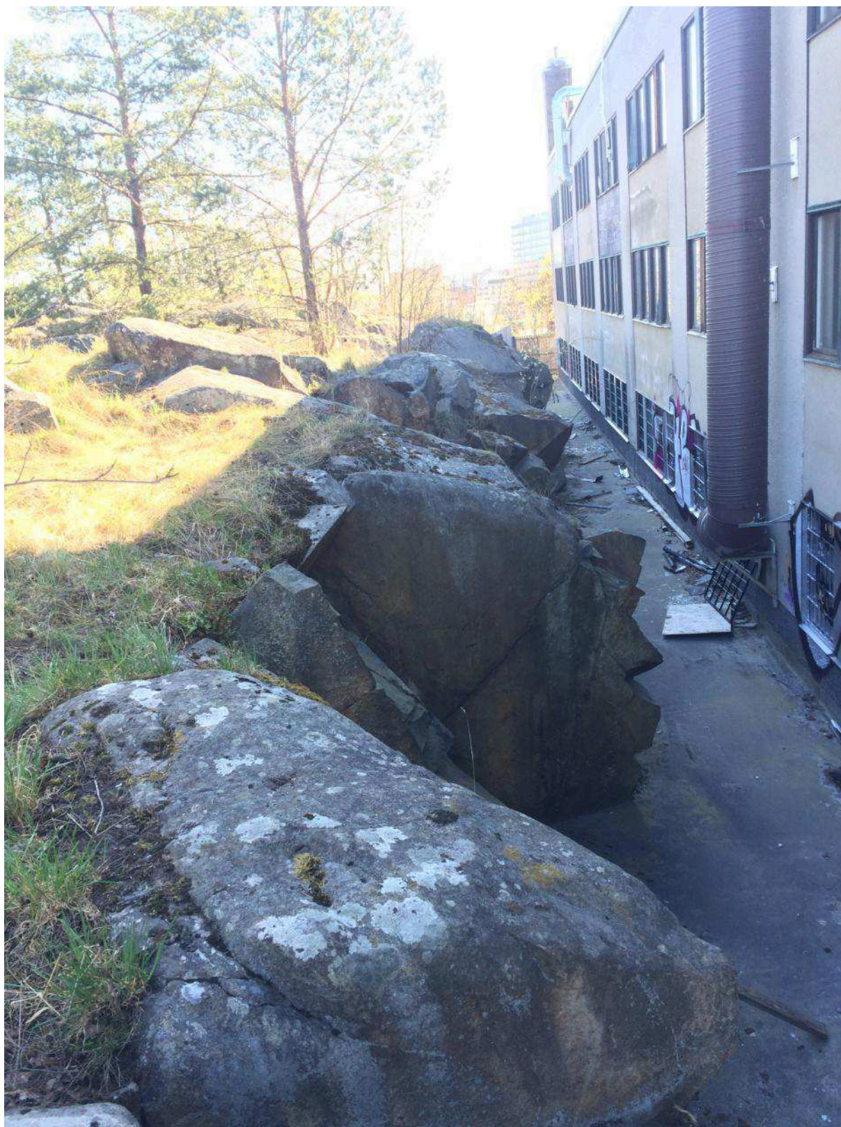
Figur 8. Krönet av den befintliga 5-12 m höga bergslänten. Naturlig sprickbildning har orsakat utfall av s k bergkilar. Det är bara ett fåtal träd och buskar som behöver röjas för att kunna arbeta ovanför slänten. Under betongen på höger sida fortsätter bergslänten 10 m till ned till den befintliga sulan.
