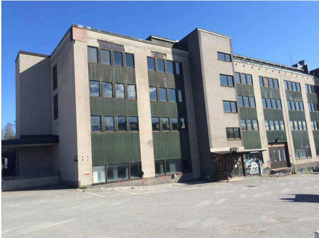
Figur 13. Huset skulle delvis kunna stå kvar som skydd vid sprängning av de höga slänter på baksidan. En genomtänkt projektering av rivningsarbeten och bergarbeten skulle kunna ge ekonomiska vinster i projektet.
