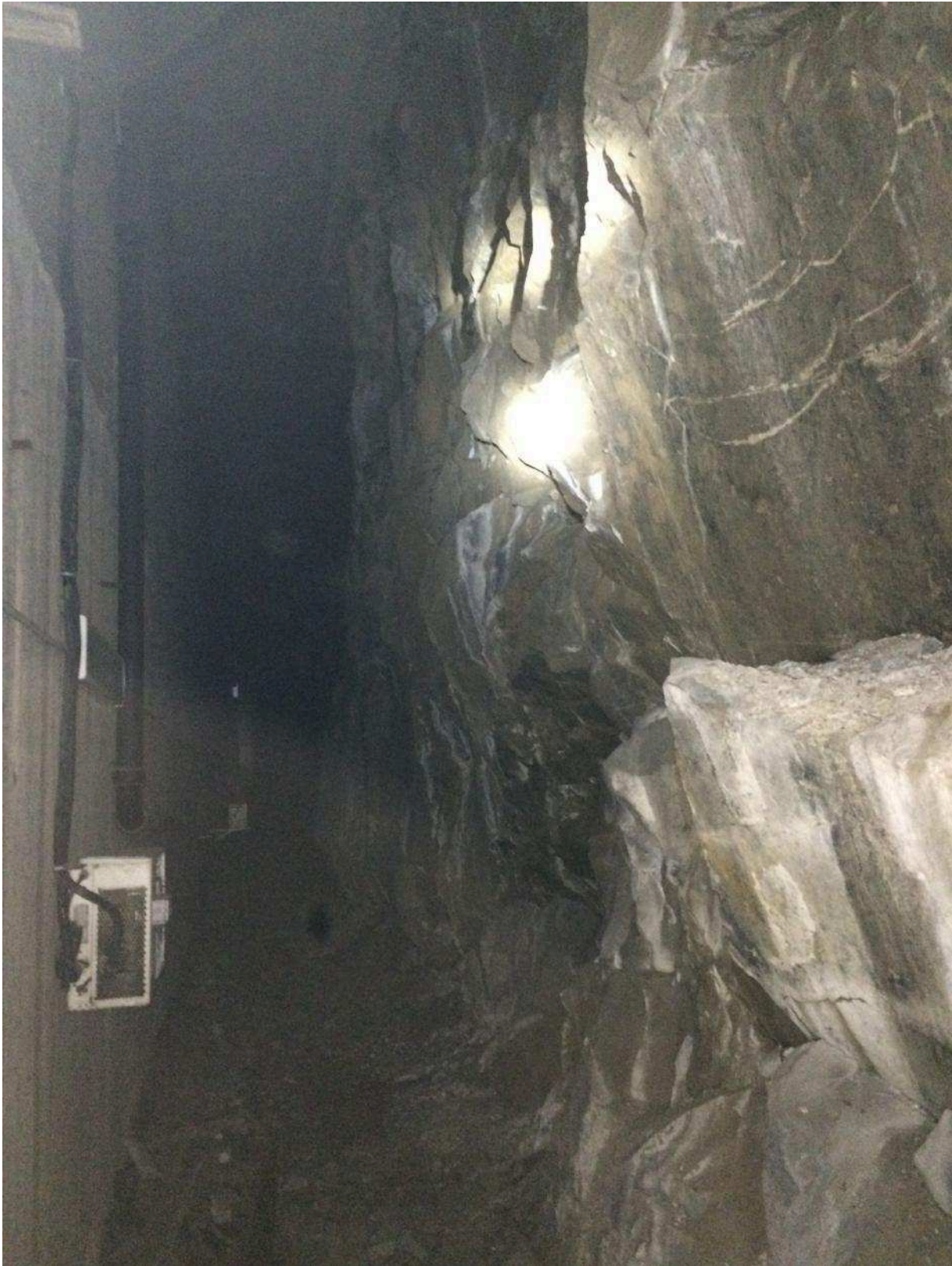
Figur 16. Trots ojämn bergkvalitet är slutresultatet av tidigare sprängarbeten i princip en vertikal slänt.
