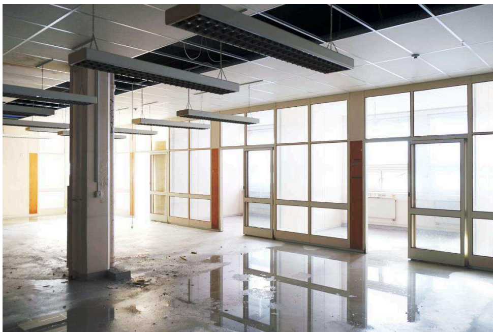
Större lokal i byggnadens östra del med glasade cellkontor efter ytterväggen. Lägg märke till skjutdörrarna i kontorens glaspazier. Här syns också en del av byggnadens stomme i form av en betongpelare.
