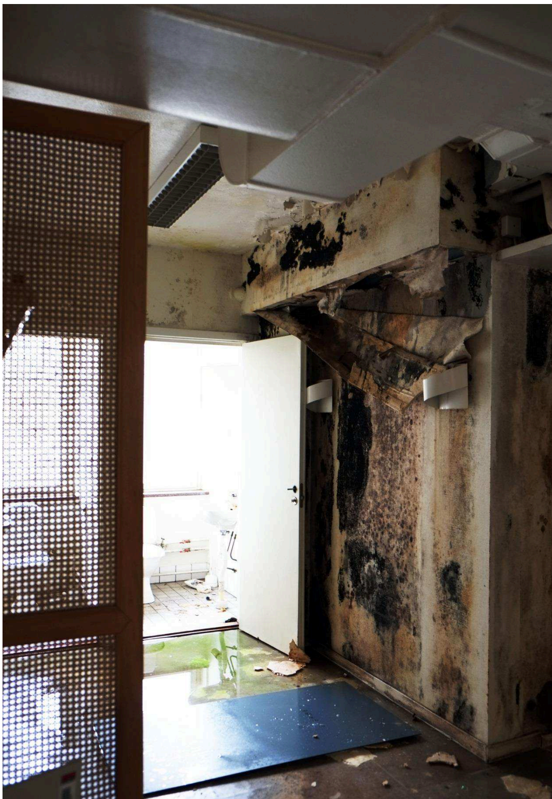
Massiva skador till följd av att stora mängder vatten läckt i samband med att kopparrör stulits utan att vattnet stängts av.
