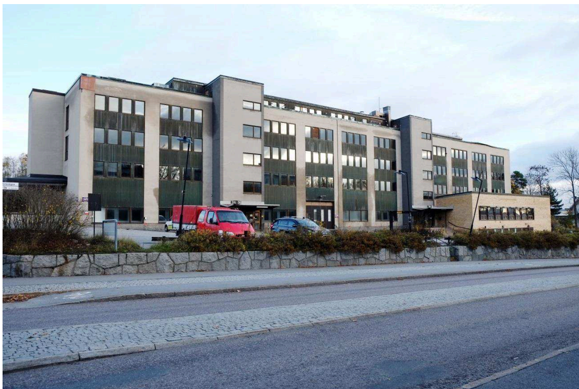
Byggnaden sedd från Bällstavägen i Söder. Notera stödmuren av rubbelmurstyp mot vägen i byggnadens förgrund. Denna typ av mur var mycket vanliga under 1900-talets mitt och det är mycket tänkbart att stenen som här använts är tagen från den sprängsten som blivit över i samband med uppförandet av byggnaden.
