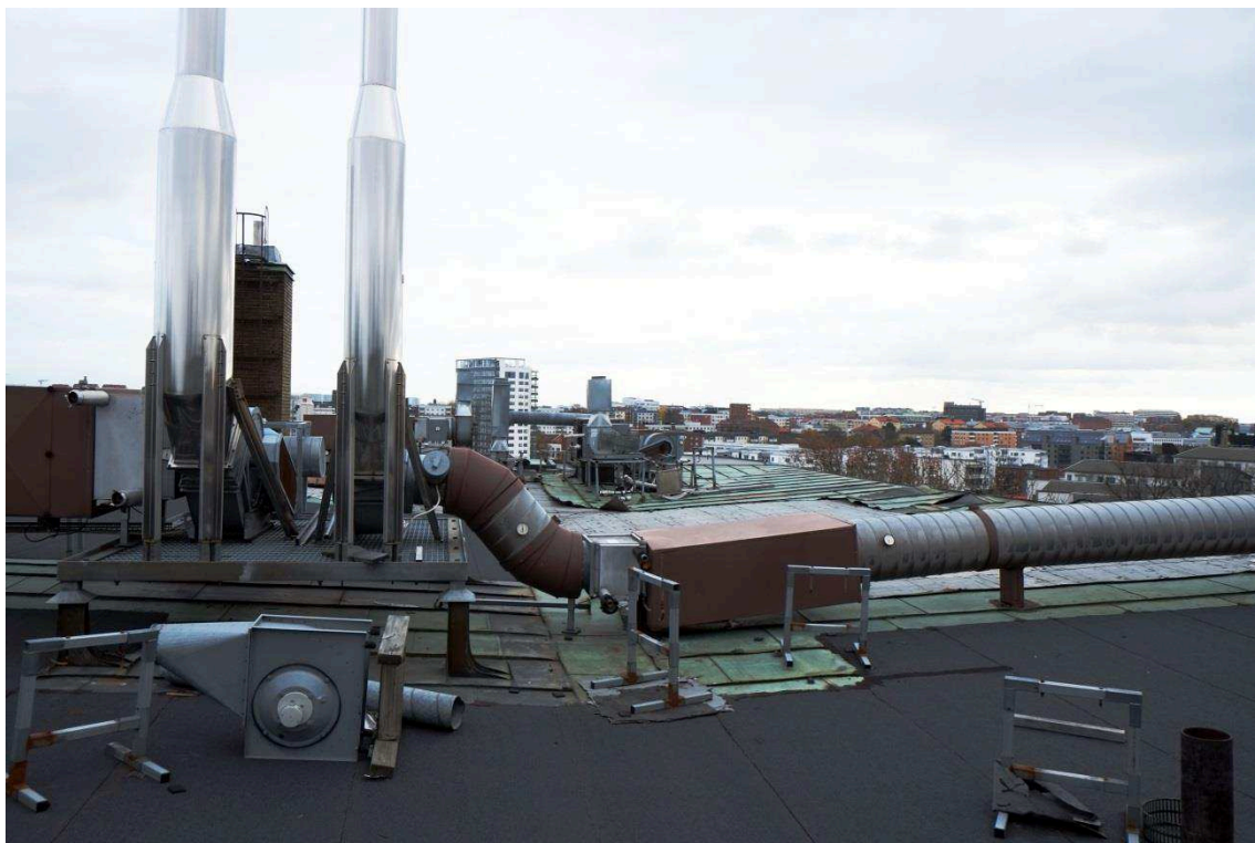
Byggnadens något inåtlutande tak med beklädnad av asfaltpapp och kopparplåt. En stor del av den ursprungliga takbeklädnaden av koppar finns inte kvar då den stulits vid inbrott någon gång 2011-2014. Detta är en starkt bidragande orsak till varför byggnaden idag är i så dåligt skick.
