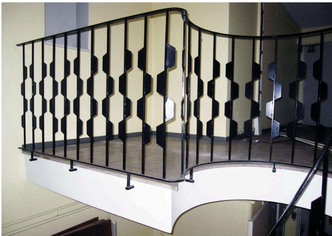
Balkongavsats i toppen på ett av trapphusen med putsad och målad betong och dekorativt utformade smidesräcken.
