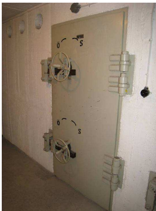
Bilder från källaren. Korridor i källare med för skolan representativ utformning. Exempel på skyddsrumsdörr.
