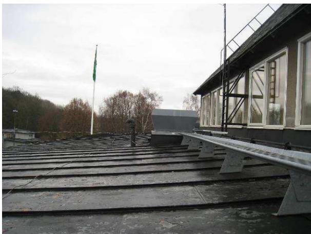
Takytorna är i huvudsak flacka och avtäckta med falsad plåt.
