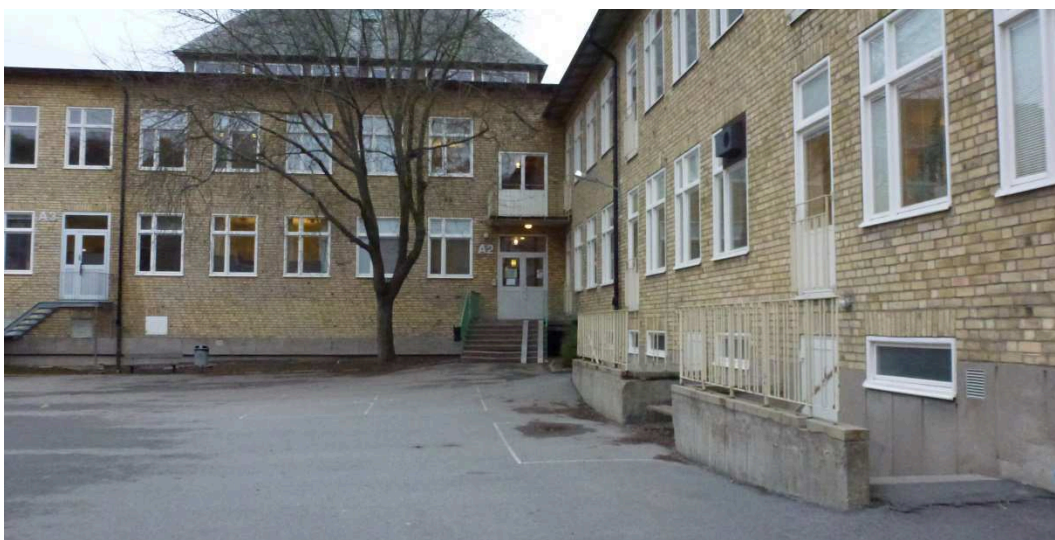
Figur 4 Foto över skolbyggnad K och F taget från skolgården. Fotot visar på ojämna markyta mot trappor på skolgården samt sprickor i asfalt (till höger i bild).
