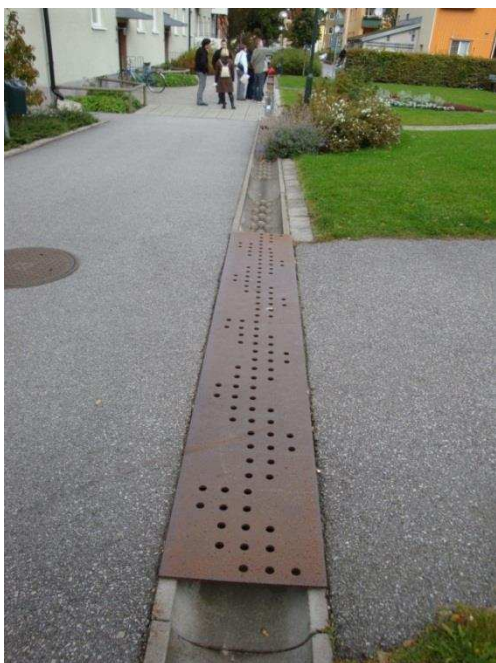
Figur 1-5 Bild på öppen dagvattenränna som används för uppsamling av takvatten och dagvatten från gångyta.
