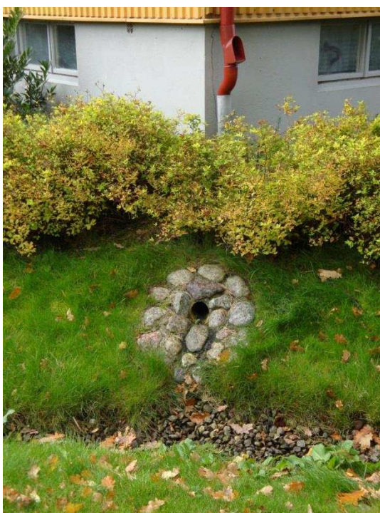
Figur 1-3 Exempel på ett erosionsskydd med ett stensatt utlopp från stuprör till avledningssystem (stensatt dike i gräsyta)
