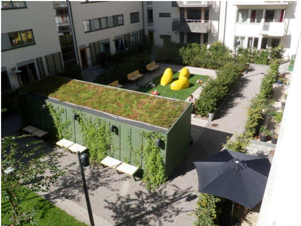
Figur 1-1 Gröna gårdar: Växtbäddar och växtlighet på bjälklag (underliggande garage), bild från Stockholm
