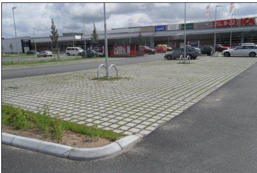
Figur 2. Parkeringsyta med genomsläpplig beläggning (Foto: Norconsult)
